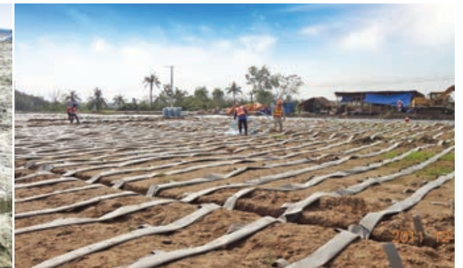
Xử lý nền đất yếu bằng phương pháp cố kết chân không/ Soft soil improvement by vacuum consolidation method
