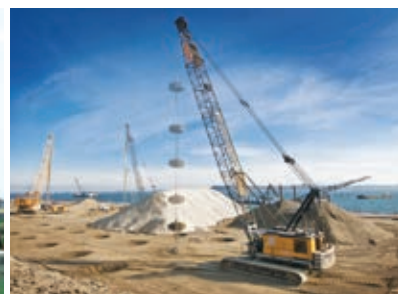
Thi công đầm động Dynamic Compaction
