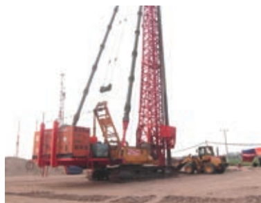
Thi công cọc cát đầm Sand compaction
