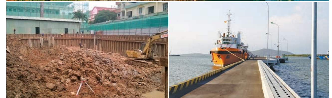
Thi công đường thủy/ Waterway construction
