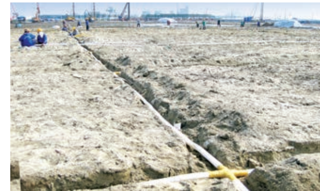
Xử lý nền đất yếu bằng phương pháp cố kết chân không/ Soft soil improvement by vacuum consolidation method
