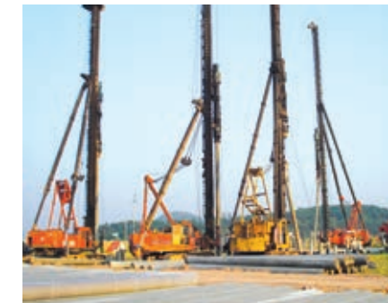
Thi công cọc bằng búa đóng Pile driving by diesel hammer/ Hydraulic hammer
