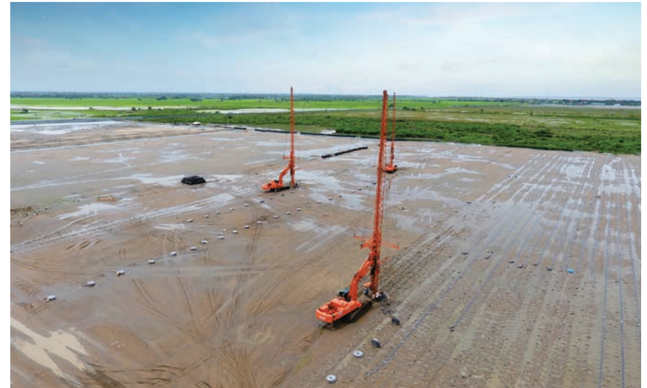
Thi công bắc thấm / PVD Installation
