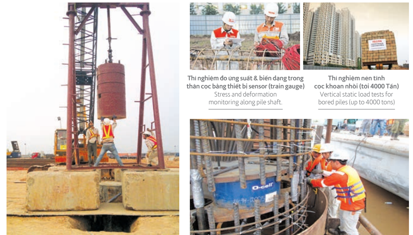
Thí nghiệm tải trọng động biến dạng lớn (PDA) Pile dynamic analysis test (PDA)
