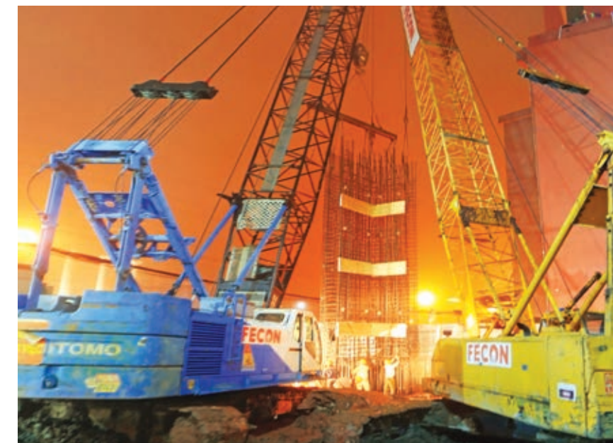
Thi công tường vách/ D-wall construction
