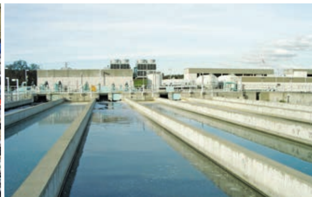
Nhà máy xử lý nước thải/ Waste water treatment plant
