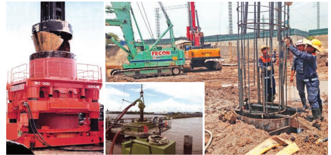
Thi Công Cọc Khoan NhòI/ Bored Pile Execution
