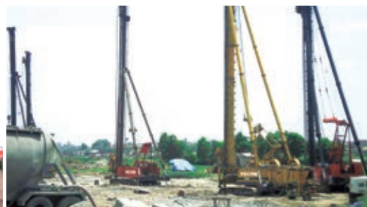
Thi công cọc xi măng đất Mixed-in-place cement column
