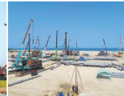
Thi công cọc bằng máy ép thủy lực Pile driving by hydraulic pressing (robot) machine
