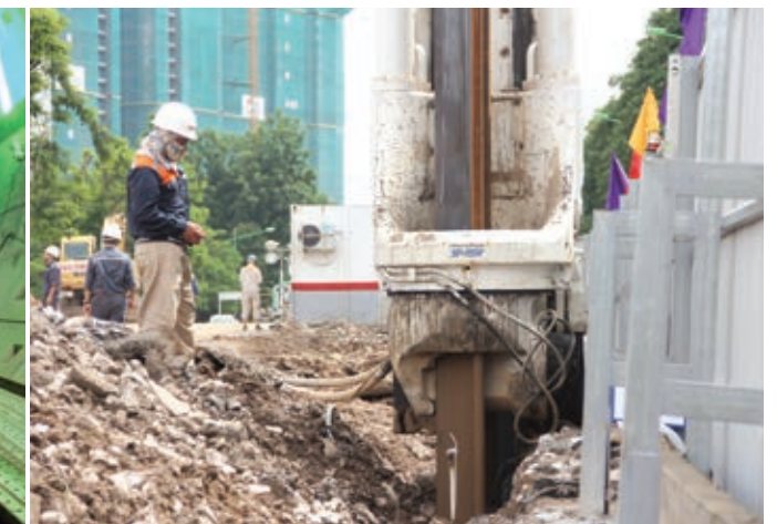
Hố đào sâu Deep excavation
