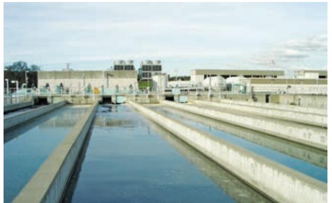
Nhà máy xử lý nước thải/ Waste water treatment plant
