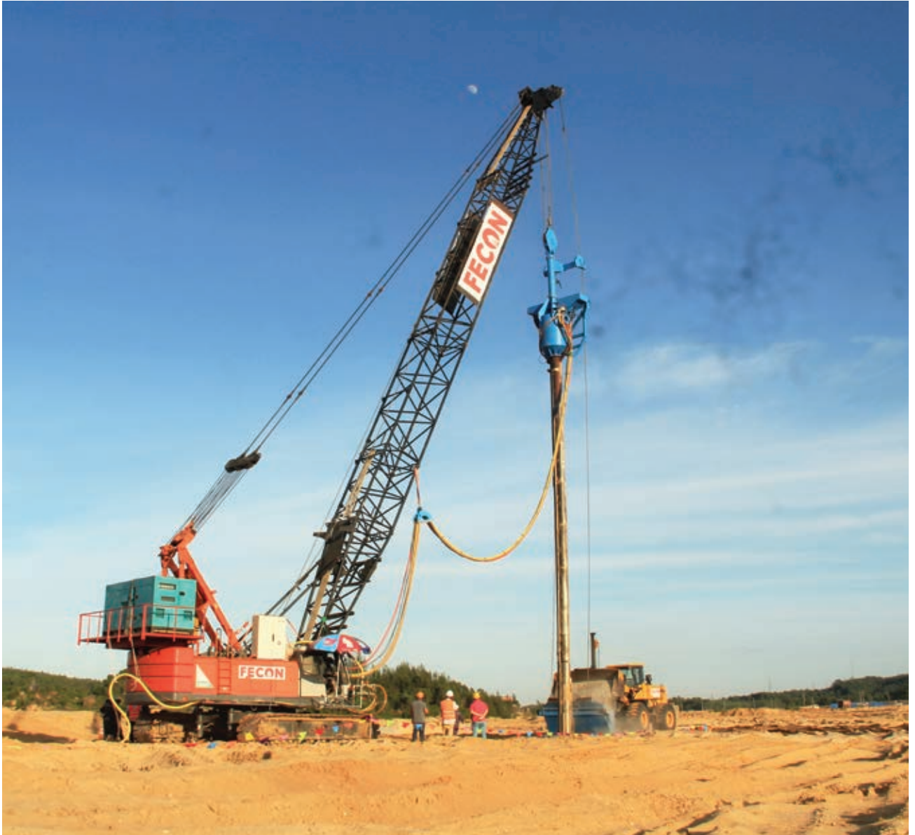
Thi công đầm rung sâu/ Vibro Compaction and Vibro Replacement
