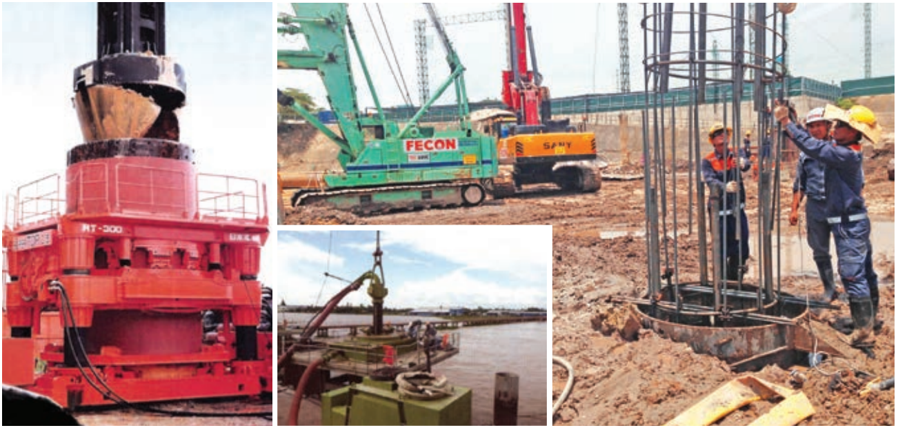
Thi Công Cọc Khoan Nhồi/ Bored Pile Execution
