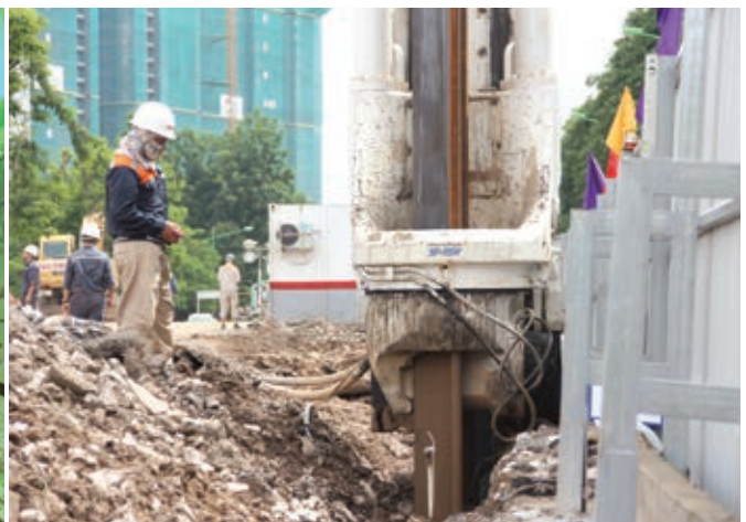
Hố đào sâu Deep excavation
