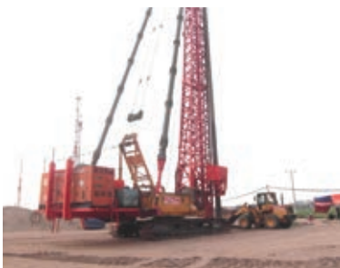
Thi công cọc cát đầm Sand compaction
