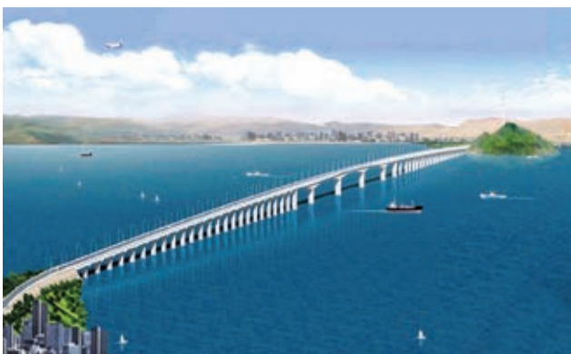
ĐƯỜNG NỐI CẦU TÂN VŨ - LẠCH HUYỀN
