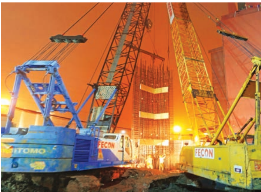
Thi công tường vây/ D-wall construction
