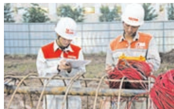
Thí nghiệm đo ứng suất & biến dạng trong thân cọc bằng thiết bị sensor (train gauge) Stress and deformation monitoring along pile shaft.
