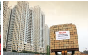
Thí nghiệm nén tĩnh cọc khoan nhồi (tới 4000 Tấn) Vertical static load tests for bored piles (up to 4000 tons)
