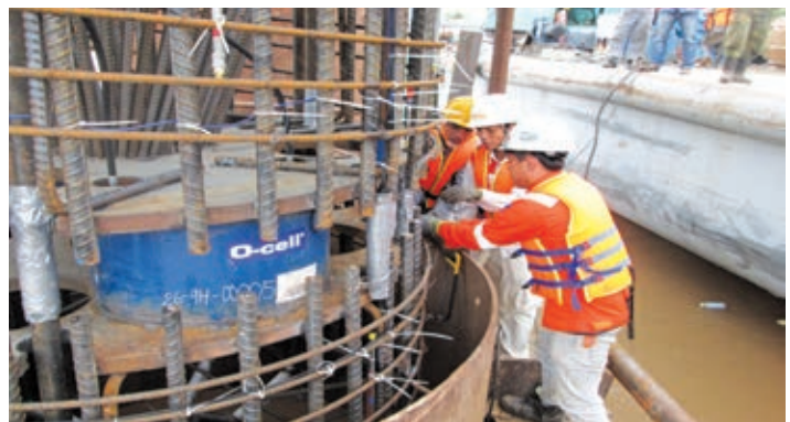
Thí nghiệm nén tĩnh cọc khoan nhồi bằng phương pháp O-CELL với tải trọng lớn O-cell load test for bored piles with high bearing capacity
