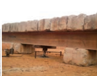
Thí nghiệm nén nền Plate loading test (PLT)
