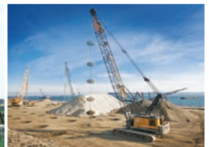
Thi công đầm động Dynamic Compaction
