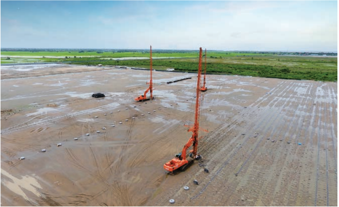
Thi công bắc thấm / PVD Installation
